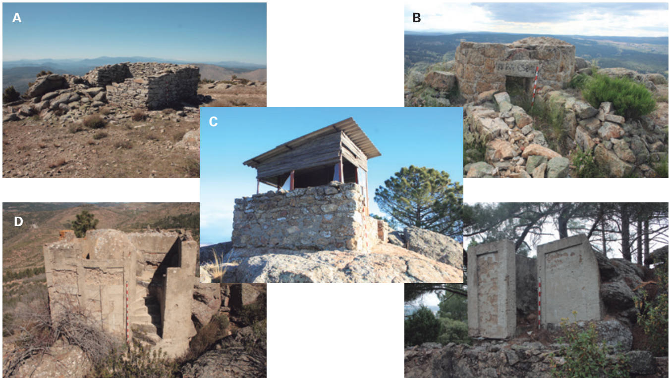
Figura 11. Observatorios. A: Cuadrangular de mampostería a hueso, con una repisa de piedra en una de las esquinas y puerta abierta al E. Conecta, visualmente, con el Cerro de San Benito (Robledillo/r, RCH). B: Obra circular (2,30 m de Ø) de sillares de granito con cemento, acceso trasero a trinchera de fábrica y puerta con dintel. Vestigios de techo blindado del estilo de los Fortines del 5º Reg. Presenta huellas de actos vandálicos (Navalespino/r, SMA). C: Obra rectangular en alto, sobre una roca y construido con mampostería y mortero de cemento. Se accede por una escalera con peldaños entre la roca. Está transformado en una caseta de vigilancia antincendios (La Atalaya/n, VMQ). D: Construcción rectangular de hormigón, levantado sobre la roca, con escalera de caracol y bancos de fábrica (Posición Casilla/n, SMA). E: Observatorio cuadrangular de fábrica, que aprovecha los afloramientos de bolos de gneis existentes y presenta un escalón de acceso. Los lienzos del exterior están decorados con reborde (Ciudad Prohibida Norte/n, SMA).
