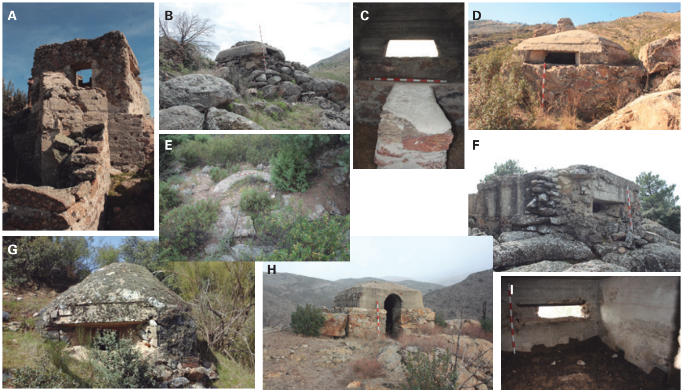
Figura 6. Nidos de ametralladora. A: Cuadrangular y hormigonado, con dos troneras y dos aspilleras (Ciudad Prohibida/n, SMA). B: Cuadrangular, de mampostería con mortero de cemento y techo hormigonado y camuflado con rocas incorporadas al fraguado, presenta una tronera frontal (Peña Mocha Baja/n, SMA). C: Interior del nido anterior, presentando el banco para apoyar el arma automática. D: Cuadrangular, de mampostería con mortero de cemento y techo hormigonado, presenta una tronera frontal (Valdemaqueda 4/n, VMQ). E: Nido en D y hormigón en toda la estructura, con dos troneras (Muro Largo/r, SMA). F: Rectangular, de mampostería con mortero de cemento y techo hormigonado y camuflado, y una tronera frontal (Ciudad Prohibida/n, SMA). G: En igloo y estructura de hormigón, cuenta con dos troneras (Estación Primo de Rivera/n, RCH). H: Rectangular, de mampostería con mortero de cemento y cúpula hormigonada (Valdemaqueda 2/n, VMQ). I: Interior del N/A de la Fig. 5F, donde se aprecian las cavidades para anclar los patines de la ametralladora Hotchkiss, por debajo de la tronera frontal.
